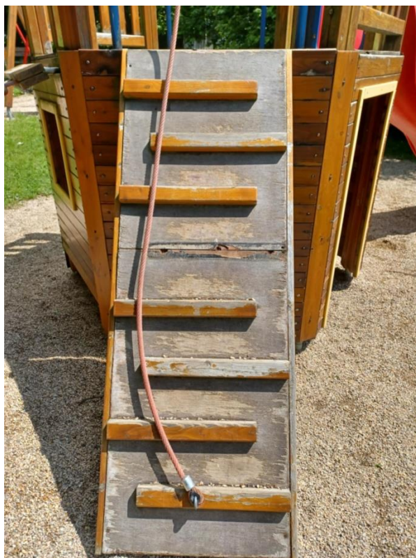
obrázek vpravo – chybějící nášlapný schod obrázek vlevo – vytrhaná boční prkna
